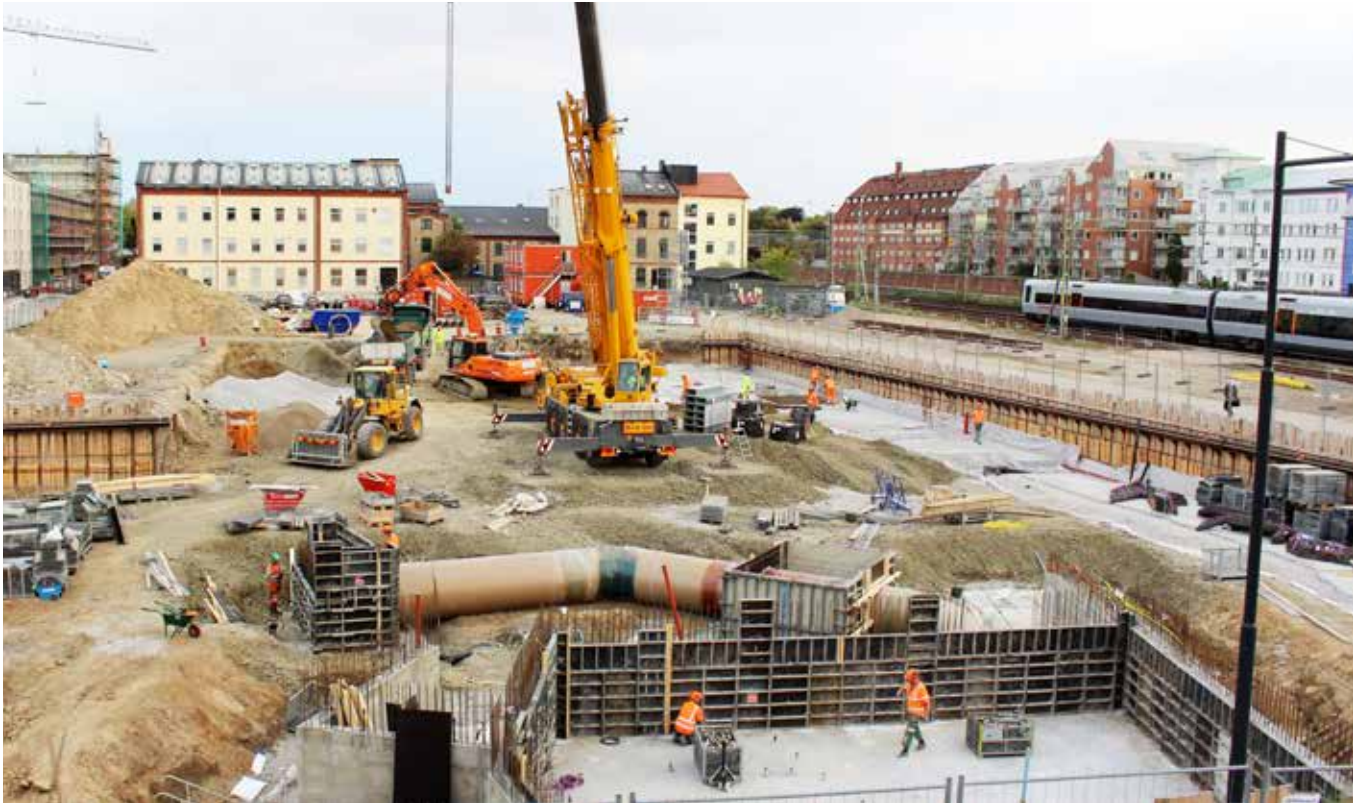
Wihlborgs har tecknat hyresavtal med Folkteandvården Skåne om 4 800 m 2 i fastigheten Posthornet 1 som just nu byggs vid Lunds centralstation.
